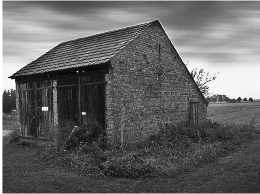
Abb. 2: Gebäude; Foto: H. STOLL
